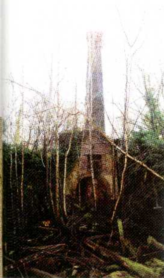
▲ Etat actuel de l'une des deux cheminées de four, le plus près du poulailler actuel, en briques fabriquées sur place.
